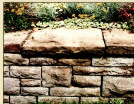
Abb. 36: Schichtmauerwerk aus bossiertem Ruhsandstein Foto: D. E. Meyer
