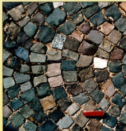
Abb. 33: „Grauwackensandstein“ als Pflasterstein in der Nähe der Orangerie auf den Farbenterrassen Foto: D. E. Meyer
