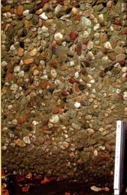
Abb. 38: Oberfläche der Waschbetonmauer an der Geologischen Wand
